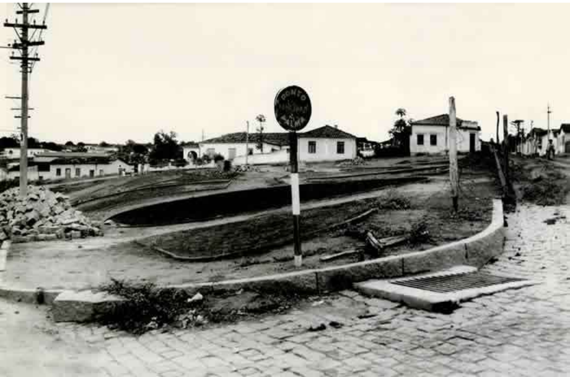
SANTA CASA DE MISERICÓRDIA EM CONSTRUÇÃO.
